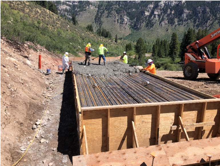
Figure 1 – Wall panel pour
